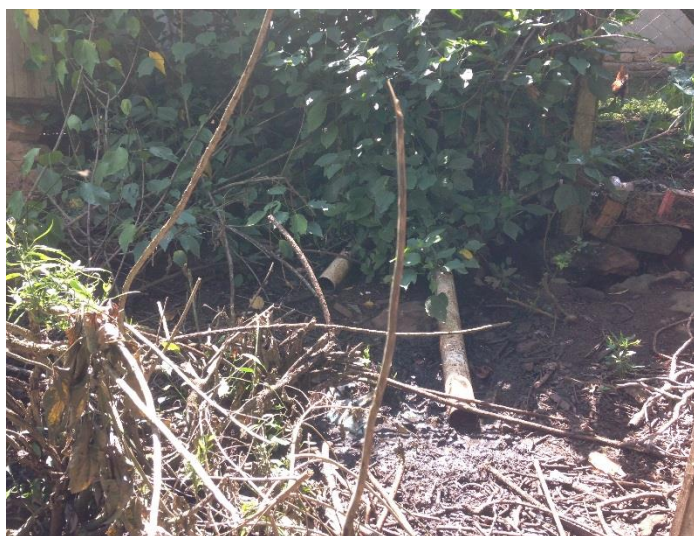
Figura 05: Esgoto a céu aberto no interior do Distrito de Monte Alverne.
